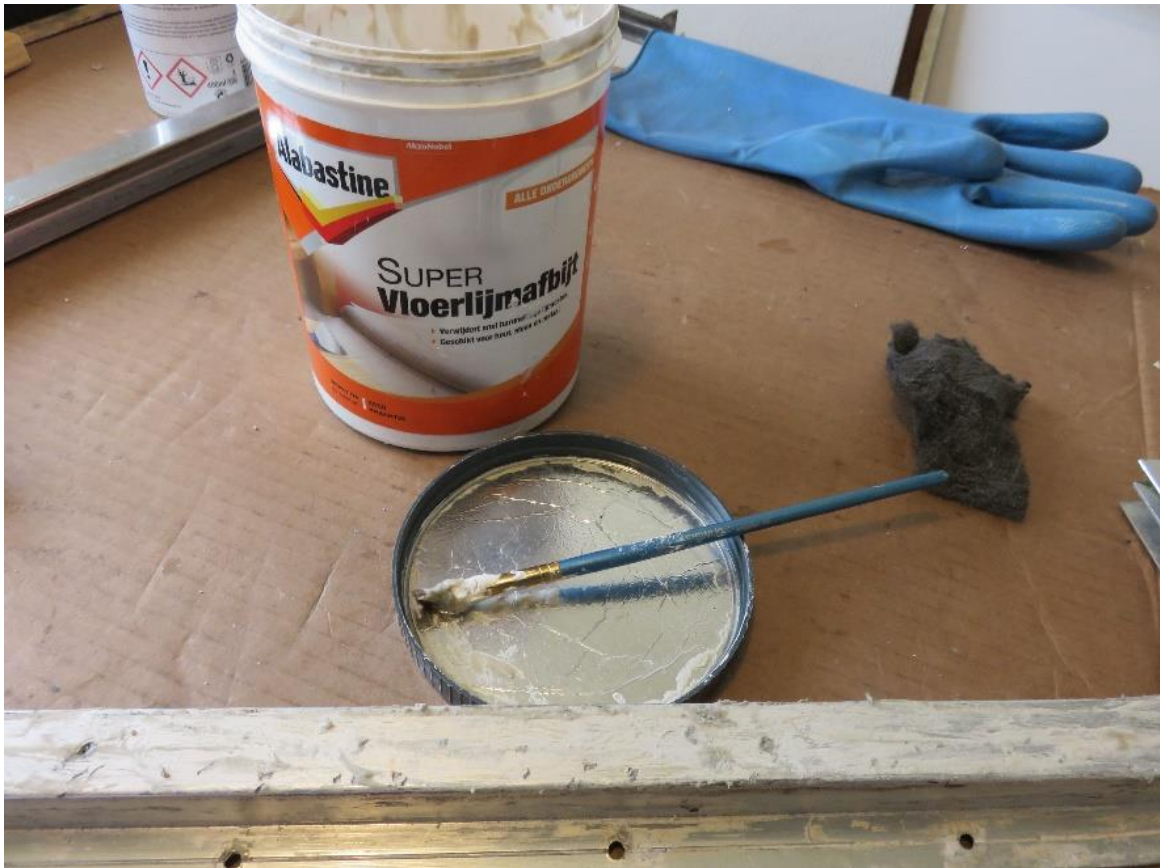
Alabastine Super vloerafbijs helpt mee lijmresten van het plakband waarmee het glas was gelijmd op te lossen.
