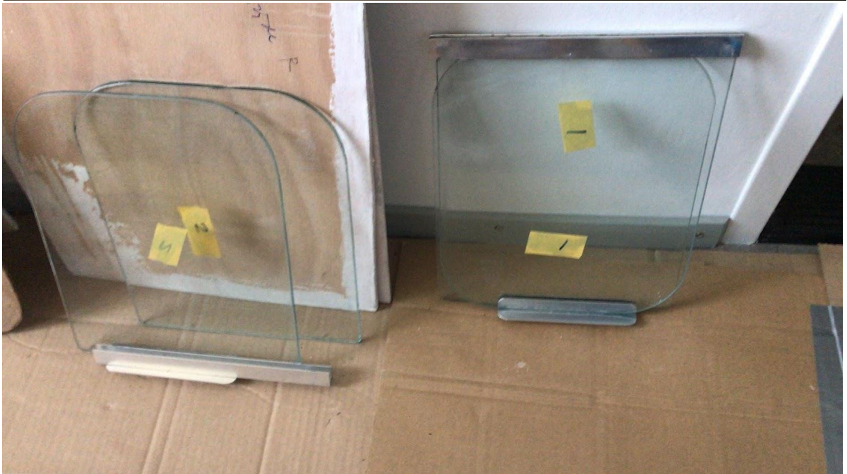
Schoongemaakte onderdelen, voor montage glas/schuifraam. Zorg dat alles is gemerkt.
